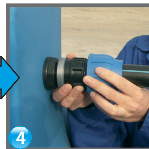
Conectarea tubului din polietilenă la racordul de compresiune
