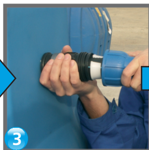
Conectarea tubului din polietilenă la racordul de compresiune
