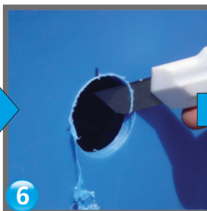
6 Se debavurează gaura finishing the hole обрезка
